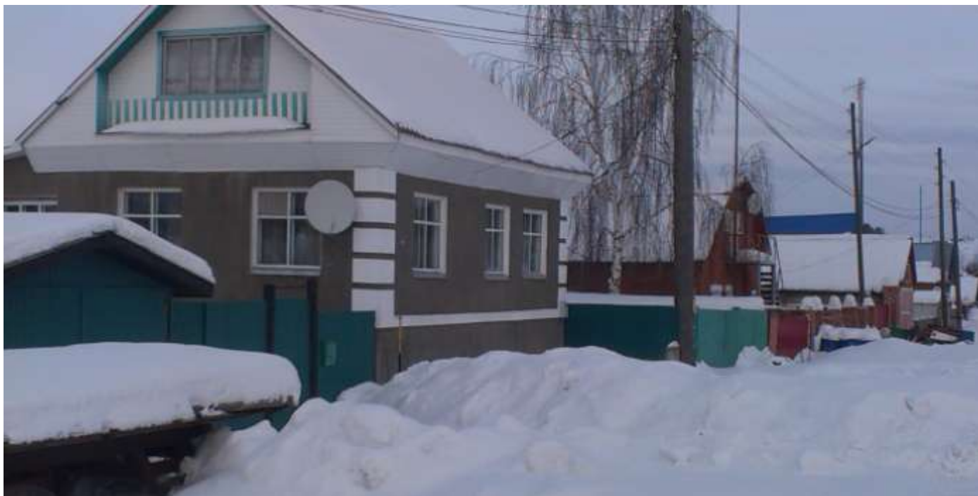
Рис. 1 Строительство распределительных газопроводов низкого давления в с. Старый Шагирт Куединского муниципального района
