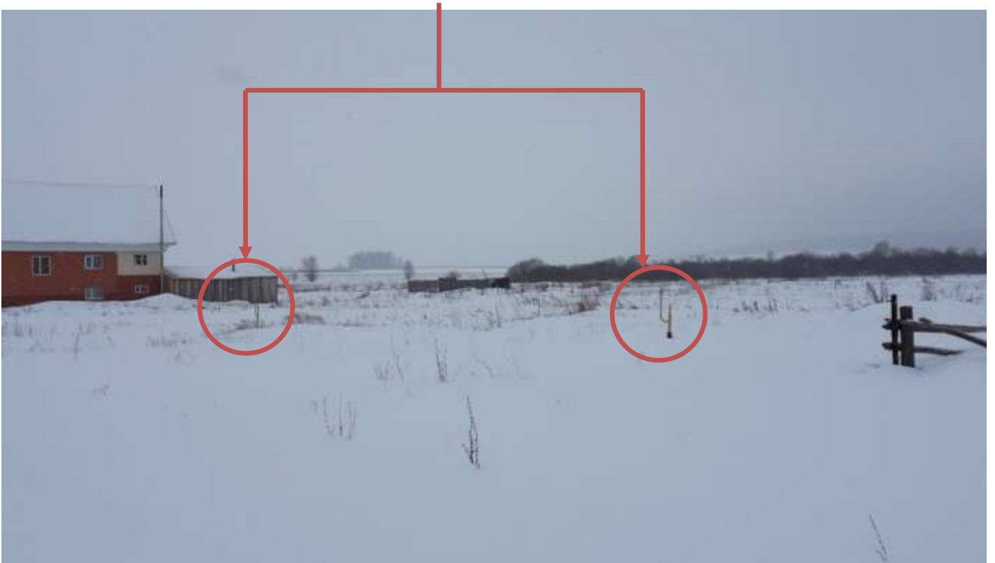
Рис. 3 Распределительные газопроводы Бардымского муниципального района с газовыми вводами в жилые дома
