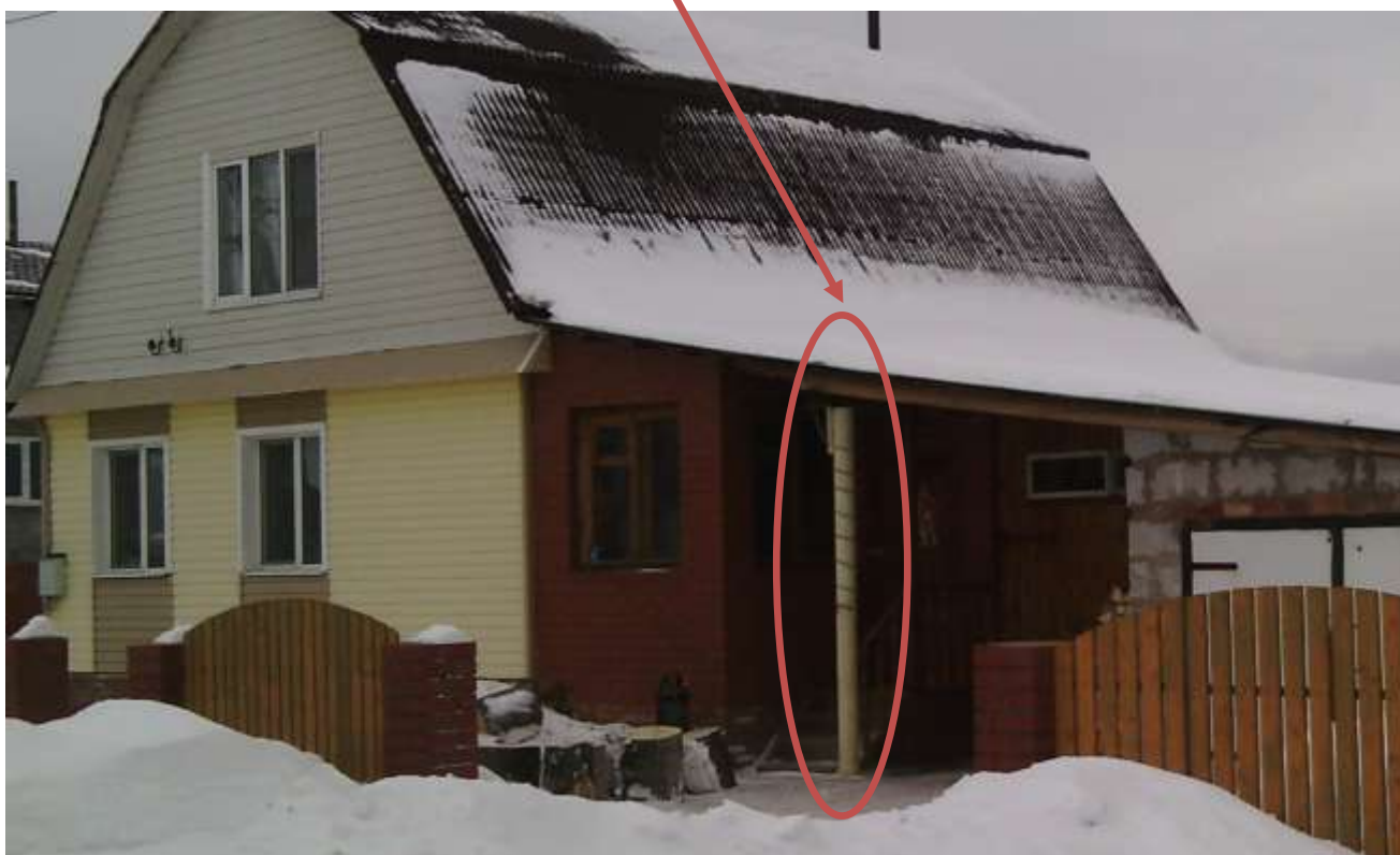
Рис. 13 Газоснабжение жилых домов в с. Нижние Муллы, д.Мураши, д. Ежи, д.Пищальниково, д. Усть-Тары. (I очередь) Пермский район
